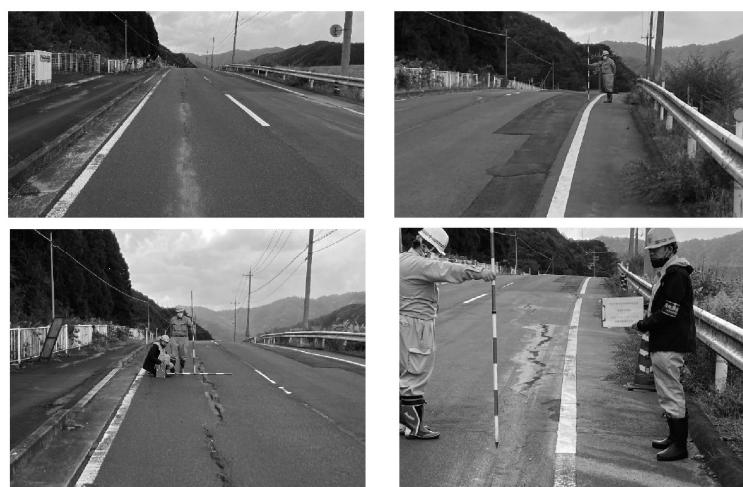
写真 1 路面に発生したクラックの状況
