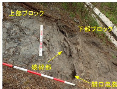
写真 2 破碎部と開口亀裂
