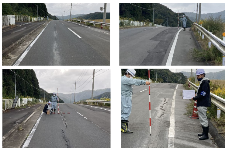
写真 1 路面に発生したクラックの状況
