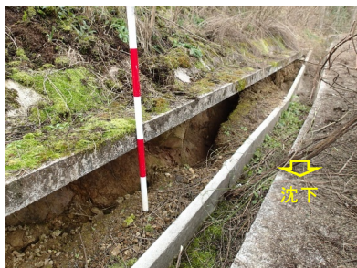
写真 1 法面小段の沈下
