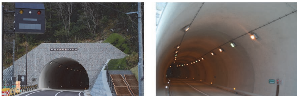
写真 1. 平成 21 年 11 月に開通した八乃洞門新トンネル
