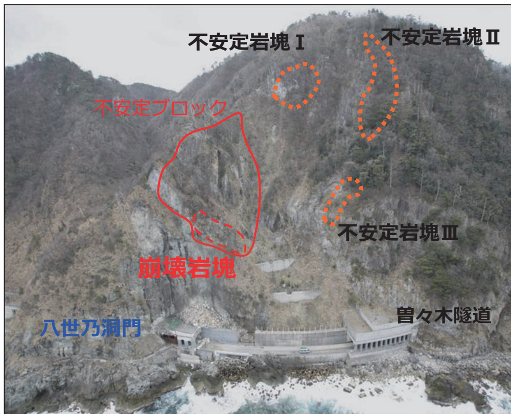
図 3. 被災箇所の不安定ブロックのほか周辺にも分布する不安定岩塊（Ⅰ～Ⅲ）
