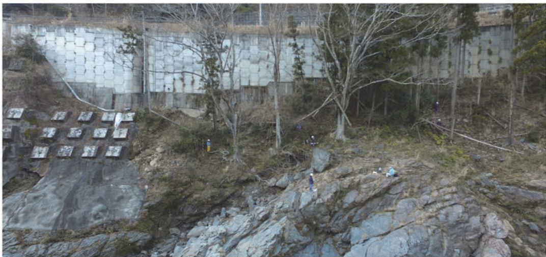
テールアルメの下方斜面の状況
