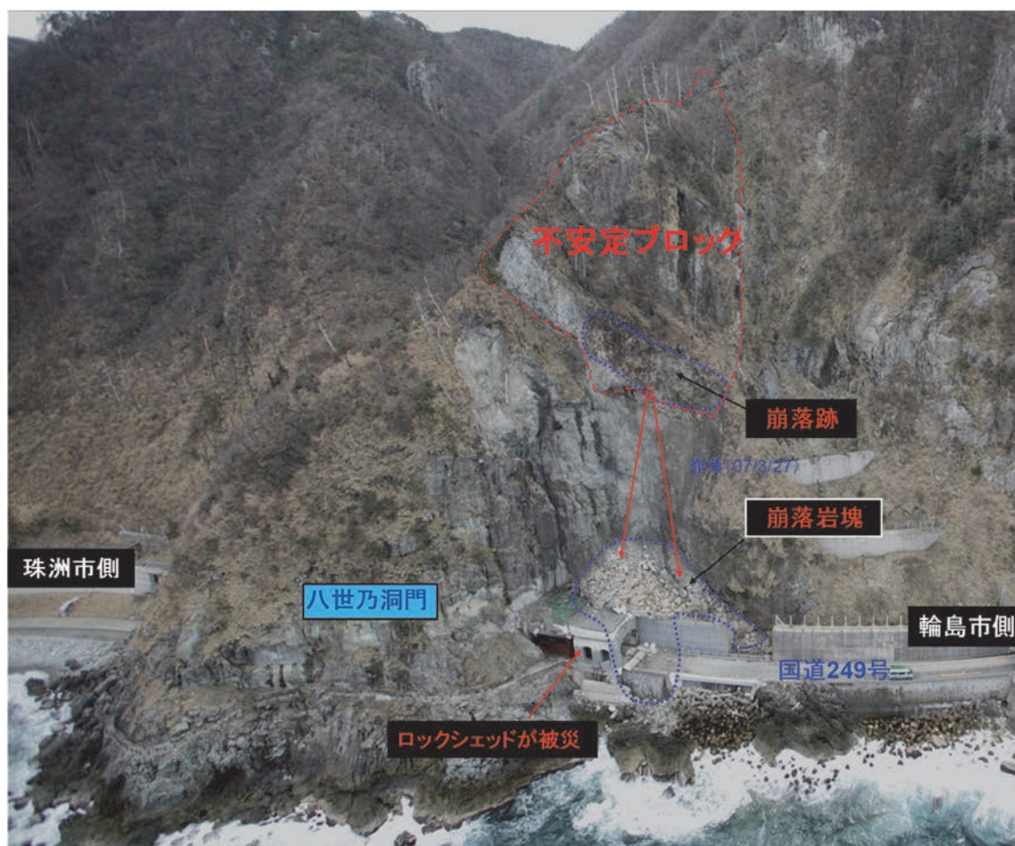
図2. 八世乃洞門 被災状況全景（平成19年 3月末被災時）
