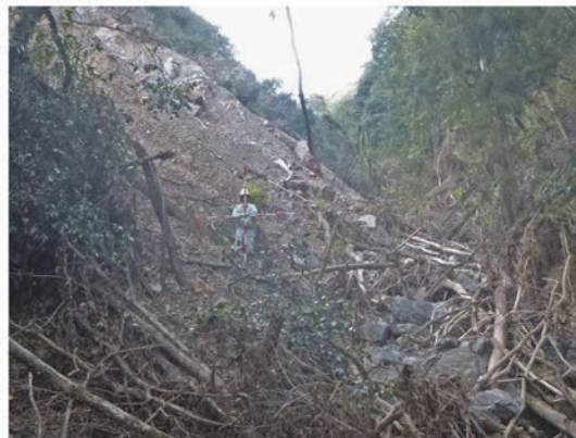
図-7. ブロック末端部の押出し
