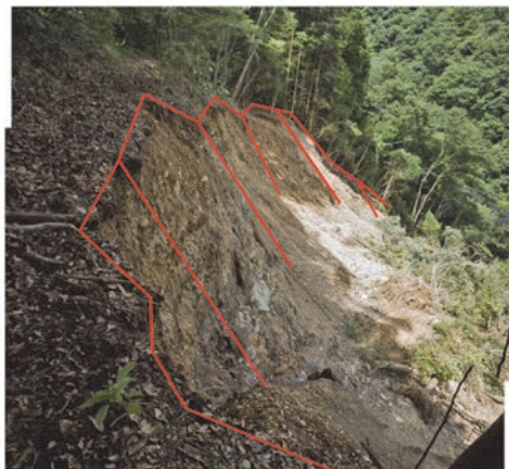
図-4. 地すべりブロック頭部の滑落
