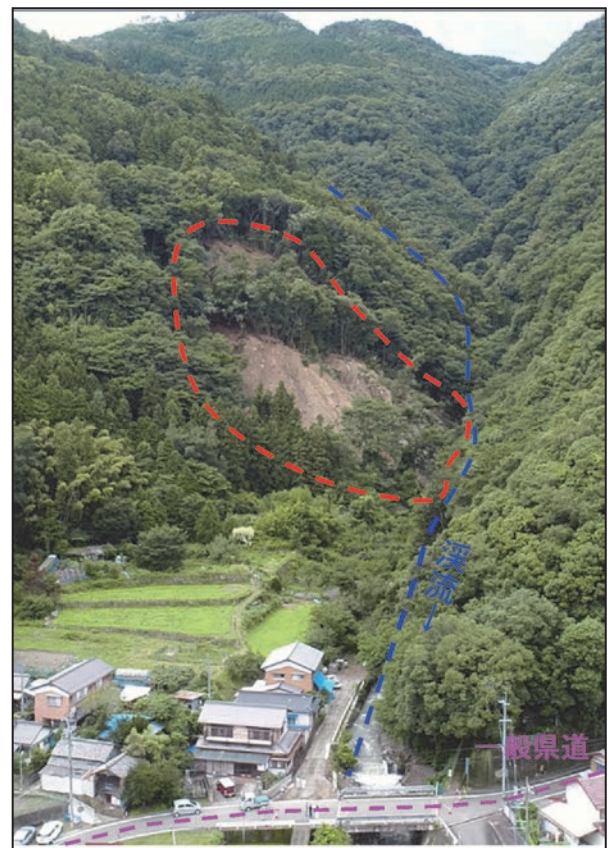
図 - 2. 被災ブロック全景
