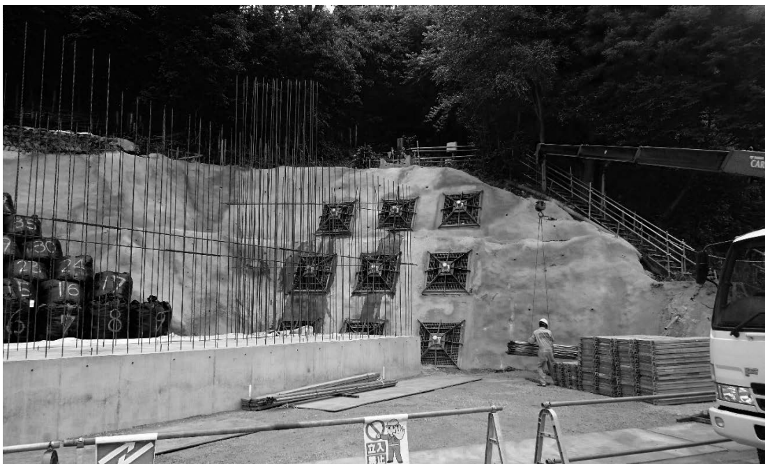
図 8 斜面安定工完了状況
