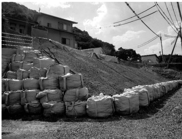
写真-4 押え盛土工施工状況
