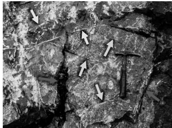
白色のカルサイト脈（黄色矢印）・・・連続面→カウント対象外 密着した亀裂（水色矢印）・・・連続面→カウント対象外 褐色を帯びた開口性の亀裂（赤色矢印）・・・不連続面→カウント対象
