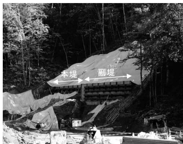
写真 2 山留め工施工状況
