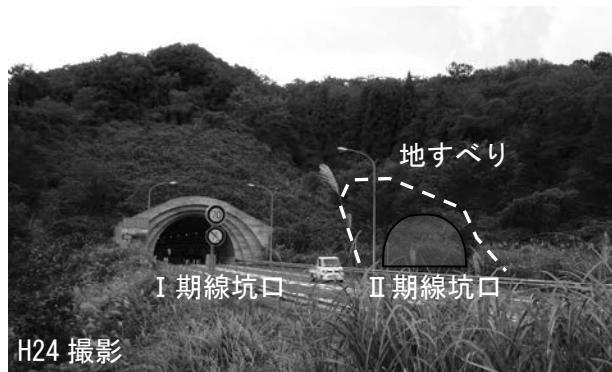
図2 金谷山トンネル終点側坑口予定地の全景
