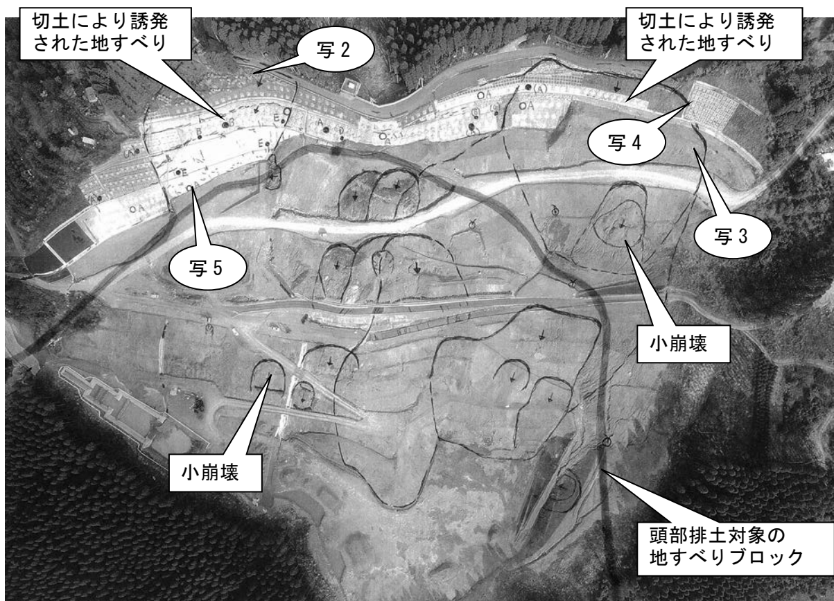
写1. 頭部排土切土法面の変状
