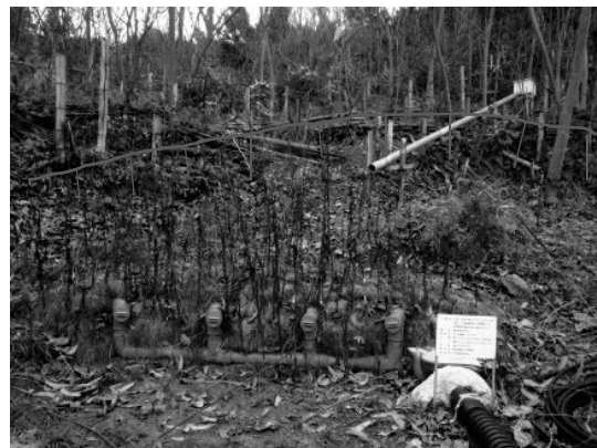
図 5 既設横孔ボーリング孔と背後の滑落崖
