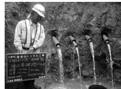
図 9 横ボーリング工排水状況 (H28/7/27 15:00 撮影)
