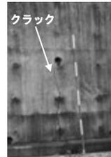
写真3 重力式擁壁のクラック
