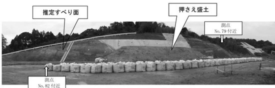
図-1 切土掘削施工中に発生した地すべり変状 応急対策として押さえ盛土工を施工
