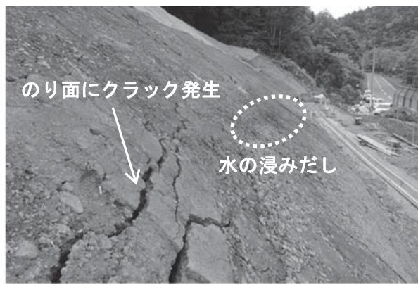
写真2 切土法面に発生した変状
