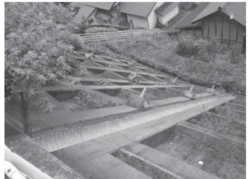
写真1 急傾斜地対策のアンカーのり面
