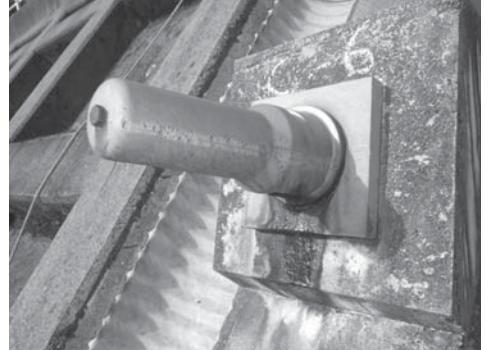
写真2 アンカー頭部の浮きと防錆油の流出
