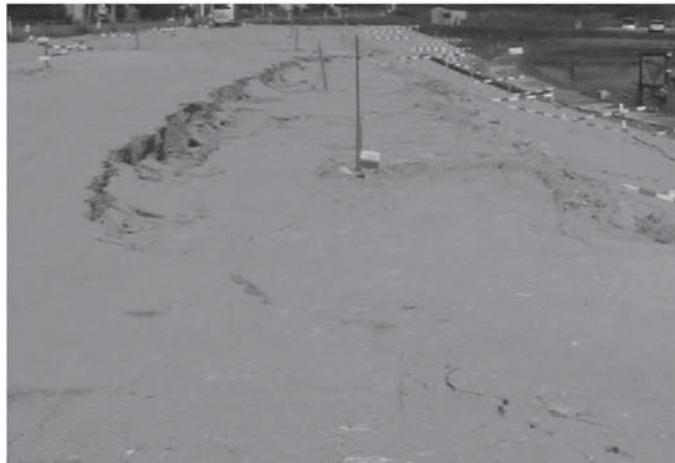
写真1 類似地盤でのすべり破壊事例
