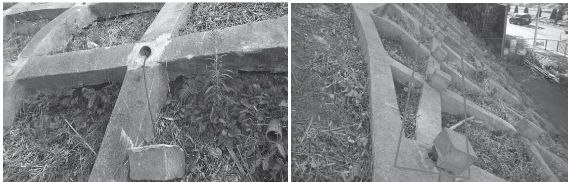
図 5 アンカーリー線の抜け出し、法枠の浮上り
