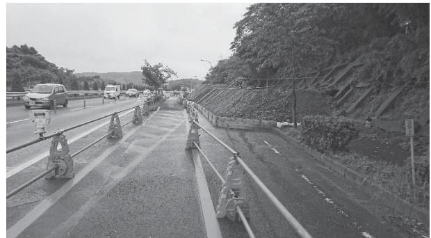
図 2 側道移設 (H28. 5)、押え盛土設置状況
