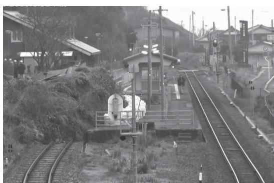
写真 2 JR田儀駅構内軌道への土砂流入
