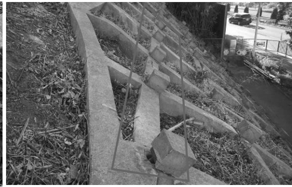
図5 アンカーより線の抜け出し、法枠の浮上り 図6 終点側法面アンカー頭部の浮上り、回転
