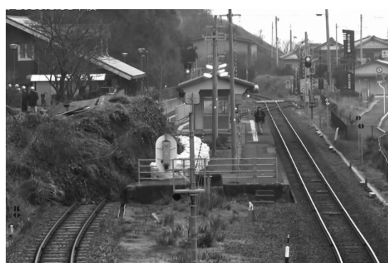
写真2 JR田儀駅構内軌道への土砂流入
