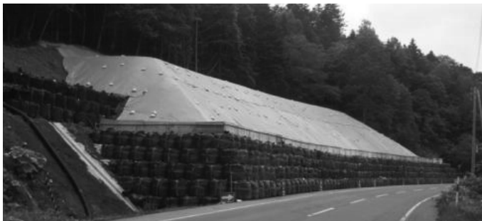
写真3 押え盛土の施工状況
