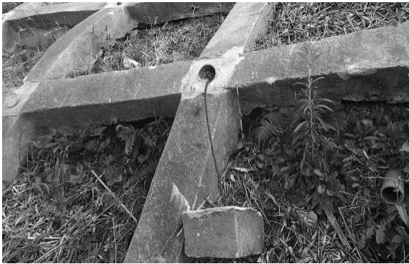
図5 アンカーより線の抜け出し、法枠の浮上り 図6 終点側法面アンカー頭部の浮上り、回転
