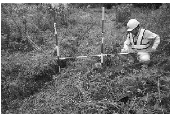
図 3 法面上方の民地に発生した滑落崖(矢印) 2 条の明瞭な滑落崖が発生、その後この段差は次第に拡大する。
