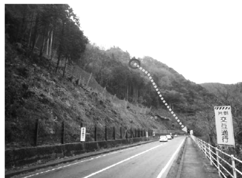
写2 現地地形と落石の発生経路
