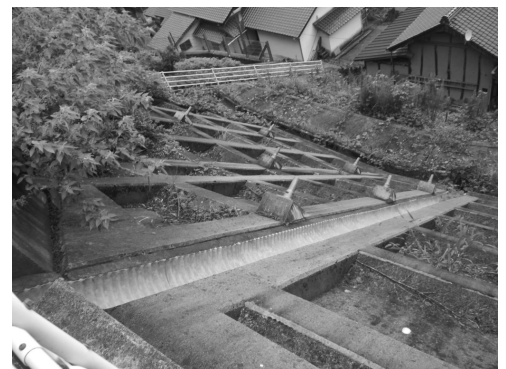
写真1 急傾斜地対策のアンカーのり面
