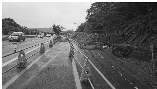
図 2 側道移設 (H28. 5)、押さえ盛土設置状況 (H28. 6 の変状発生直後に設置)
