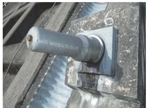
写真2 アンカー頭部の浮きと防錆油の流出
