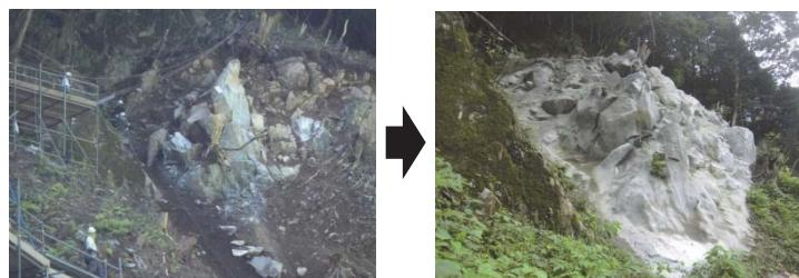
写9 不安定岩塊除去の崖面状況と仮設モルタル吹付工を提案し実施された。
