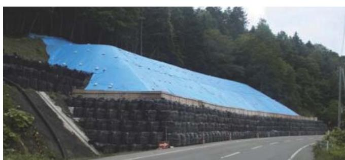
写真3 押え盛土の施工状況
