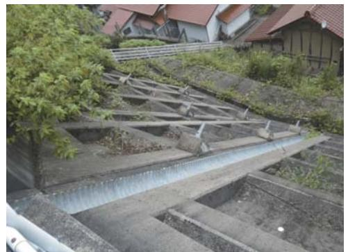
写真1 急傾斜地対策のアンカーのり面
