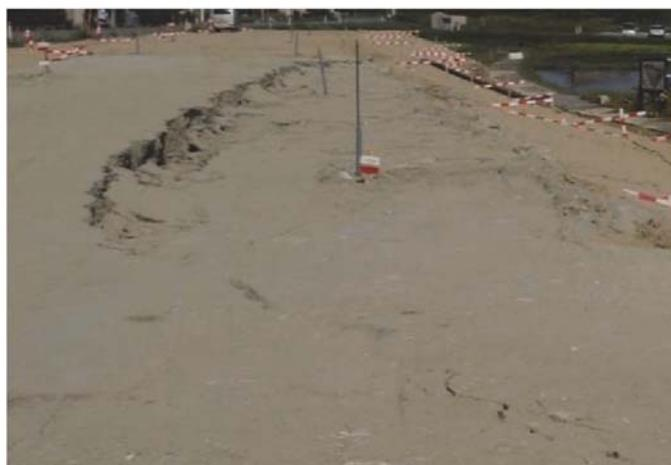
写真1 類似地盤でのすべり破壊事例
