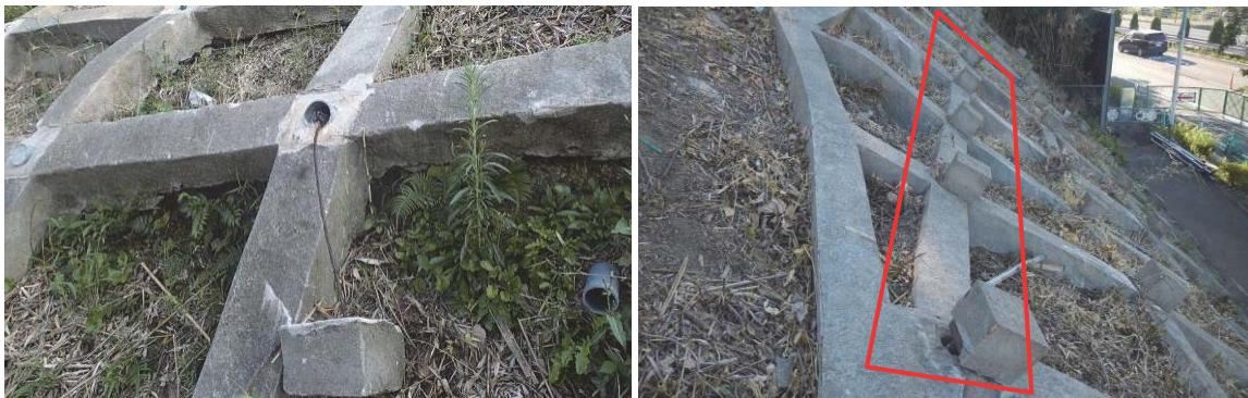
図 5 アンカーリードの抜け出し、法枠の浮上り
