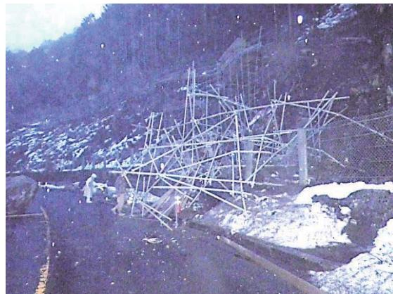
写4 落石が破壊した仮設足場
