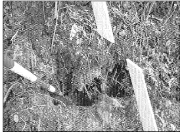
写真2 冠頭部の亀裂と抜板
