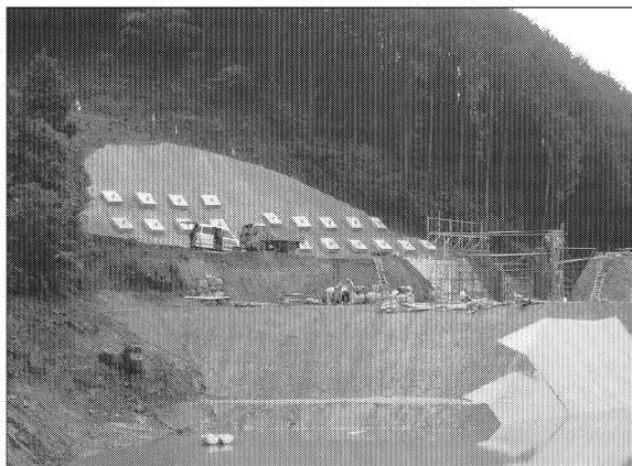
写真5 アンカー工の施工状況
