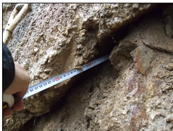
写真4 掘削面に生じた押出し
