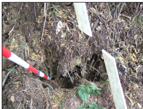
写真2 冠頭部の亀裂と抜板
