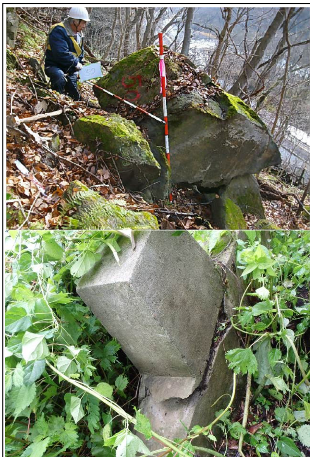
写真 変状発生箇所の例
