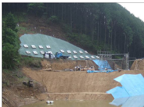
写真5 アンカー工の施工状況
