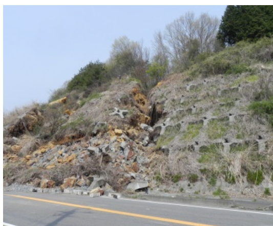
写真 1 崩壊したアンカーのり面
