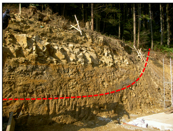
写真3 洪水吐掘削面と亀裂
