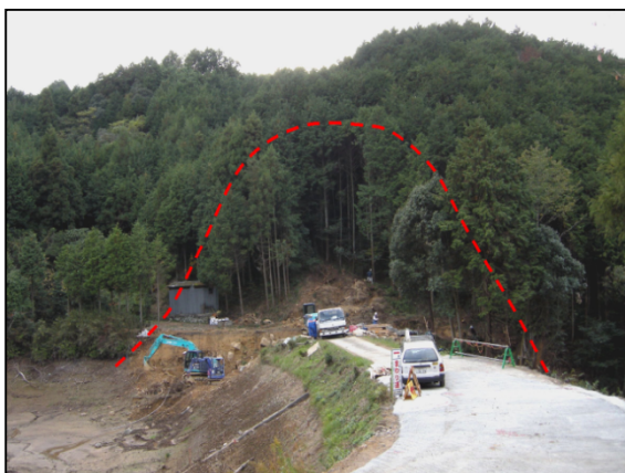
写真1 地すべりブロック全景
