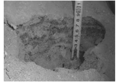
写真 4 開口クラック部で 確認されたアイスレンズ
