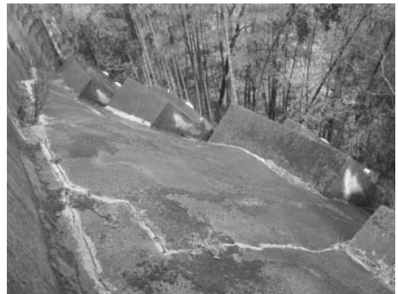
写真-1 アンカー周辺のクラック変状
