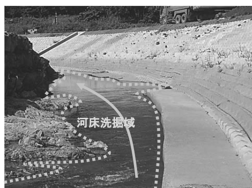
図2 新河道（暫定半断面）の河床洗掘状況
