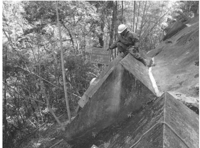
写真-2 受圧板と現場打ち角度調整台座
