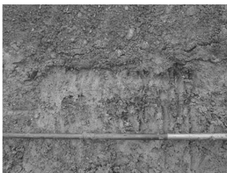
写真1 崩壊基底面の軟弱粘性土層
