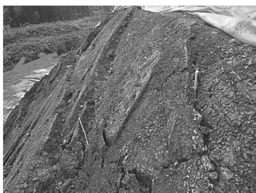
図1 左岸側 1 : 1.2 暫定切土法面の トップリングによる変状状況
