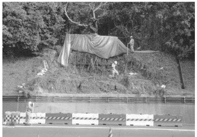
図2 災害発生箇所（2例）
