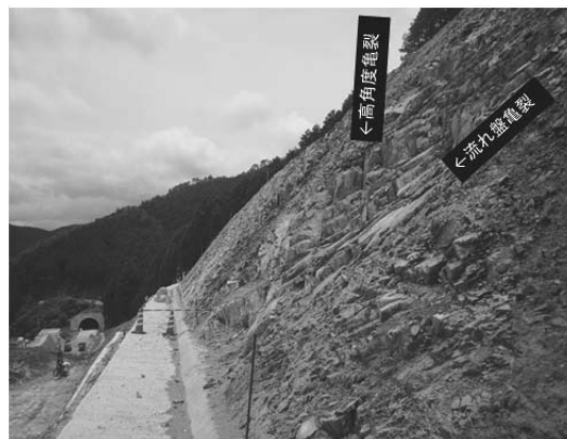
図3 くさび状の抜け落ち
