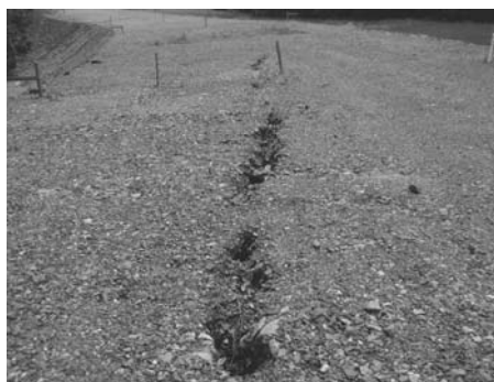
図4 発生した亀裂の状況
