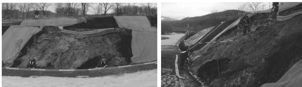
写真 1 崩壊地全景(左正面・右横断)
