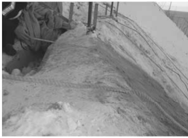
写真 2 小段ステップ 法肩部の持ち上がり
