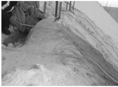
写真 2 小段ステップ 法肩部の持ち上がり
