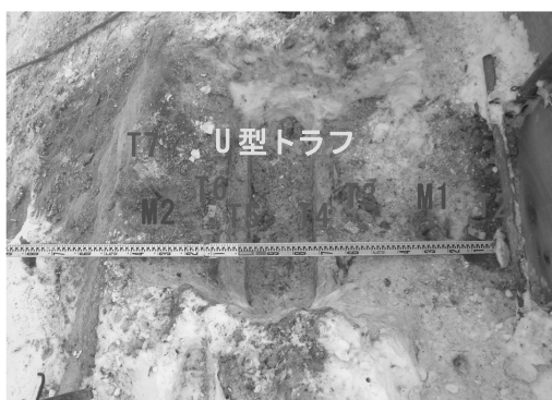
写真 5 計器設置状況
