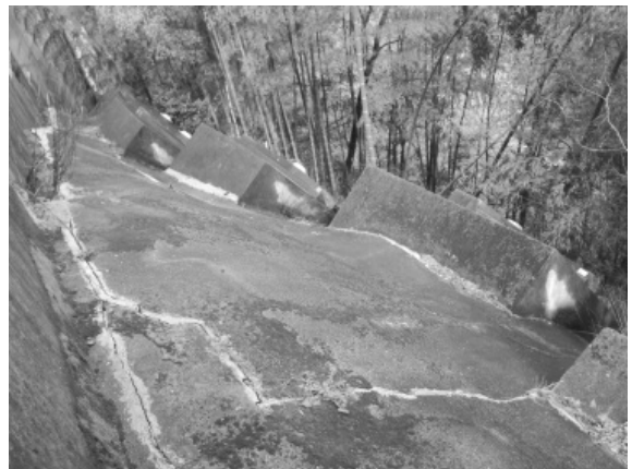
写真-1 アンカー周辺のクラック変状
