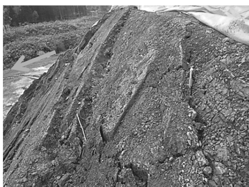
図1 左岸側 1 : 1.2 暫定切土法面のトッピングによる変状状況
