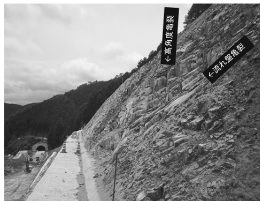
図3 くさび状の抜け落ち
