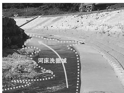
図2 新河道（暫定半断面）の河床洗掘状況
