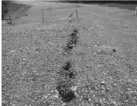
図4 発生した亀裂の状況
