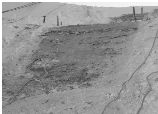
写真 1 凍上発生時の 切土法面工事状況
