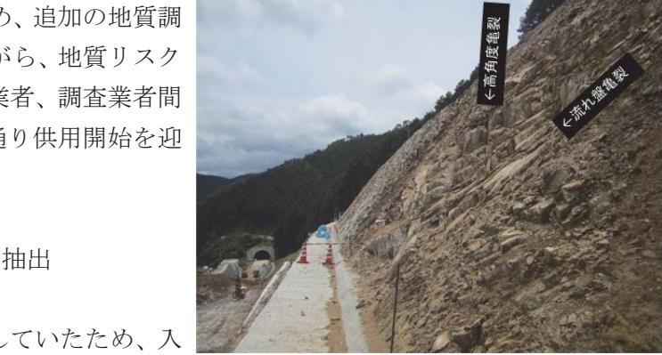
図3 くさび状の抜け落ち
