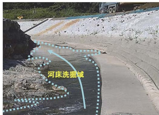
図2 新河道（暫定半断面）の河床洗掘状況
