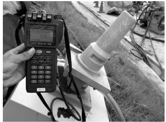
図 5. ハンディーロガーを用いた 荷重計測状況
