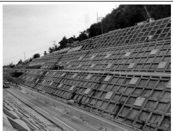
写真-3 H23年右側法面对策施工状況
