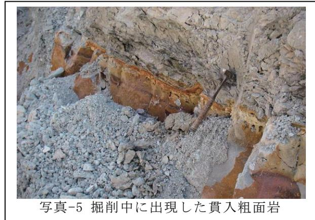
写真-5 掘削中に出現した貫入粗面岩
