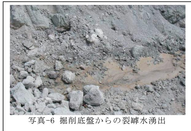
写真-6 掘削底盤からの裂隙水湧出
