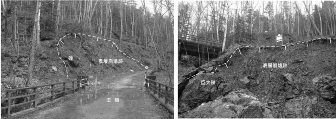
写真1 橋台背後の斜面状況、小規模な表層崩壊が目立つ
