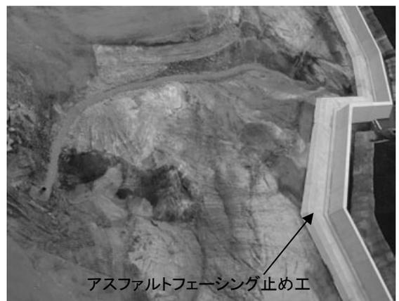
写真-2 アスファルトフェーシング 施工前の基礎掘削断面
