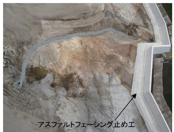
写真-2 アスファルトフェーシング 施工前の基礎掘削面
