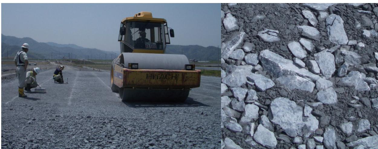
写真1 トンネルずりによる盛土
