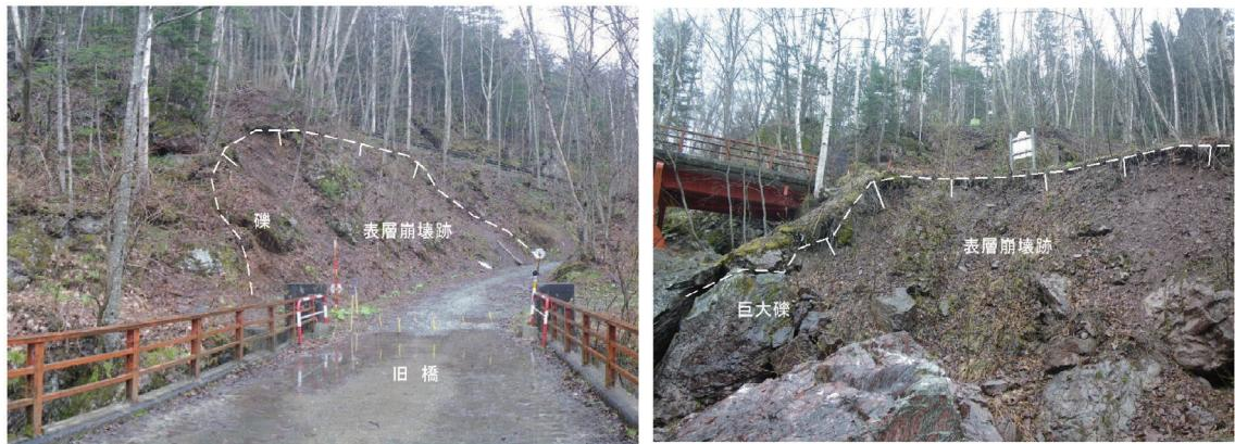
写真 1 橋台背後の斜面状況、小規模な表層崩壊が目立つ
