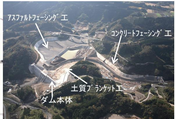
写真-1 貯水池対策工の施工状況
