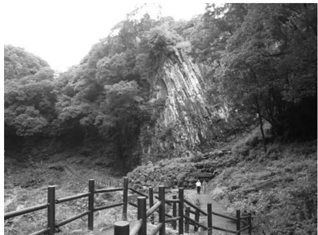
図-2 遊歩道脇の崩壊箇所対策後の状況
