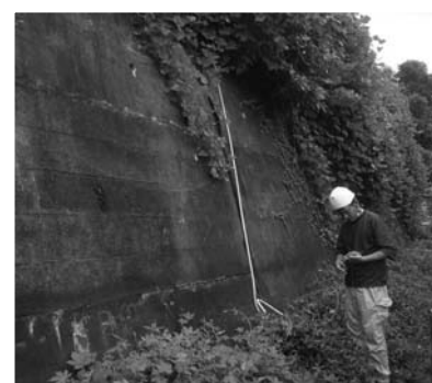
図 9 通電確認状況
